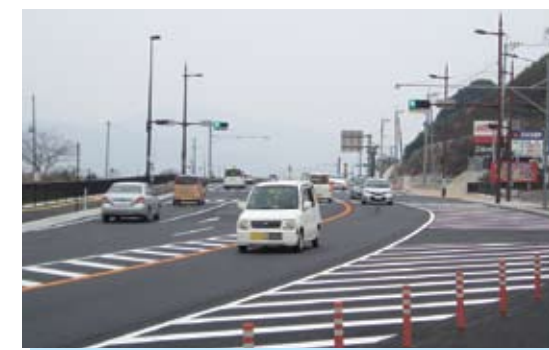
国道34号大村拡幅 大村市 4車線拡幅により交通渋滞の解消と交通安全の向上が図られました
