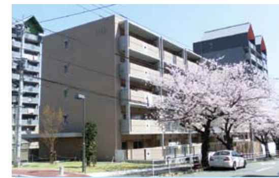
県営住宅(滑石団地1-12,13棟) 長崎市 建替工事によって、県営住宅の居住機能及び耐震性の向上が図られました
