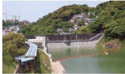
中島川の洪水を調節する本河内低部ダムの概成（平成23(2011)年度）
