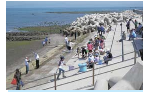
島原港海岸保全事業 島原市 高潮被害を抑制し、伝統漁法「スキイ」を楽しめる親水式護岸を整備しました
