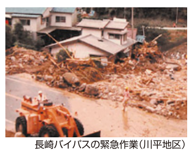
長崎バイパスの緊急作業(川平地区)
