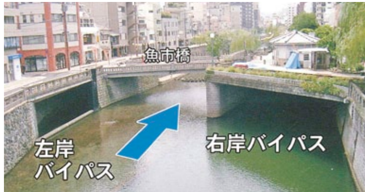
中島川・眼鏡橋の現地保存のためのバイパス水路の完成（平成18(2006)年度）
