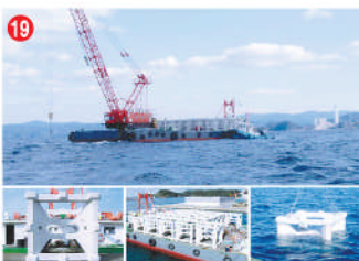
19 工事名 長崎南地区広域漁港整備工事(崎戸島南2工区) 施工者 黒瀬建設㈱ 技術者 河野 正一 工事内容 魚礁を造り、海中に設置する工事です。
