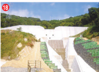
18 工事名 小奈良尾臨川通常砂防工事 施工者 大宝建設㈱ 技術者 戸村 敬一 工事内容 土石流から家を守る工事です。
