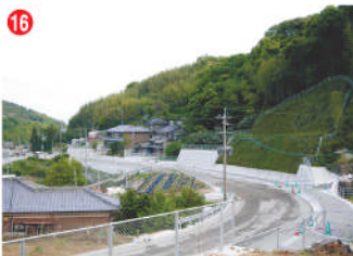
16 工事名 主要地方道野母崎線道路改良工事(3工区) 施工者 ㈱中嶋組 技術者 高谷 力 工事内容 道路を新設する工事です。
