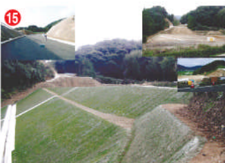
15 工事名 主要地方道佐世保吉井松浦線道路改良工事 施工者 松浦建設㈱ 技術者 村山 司之 工事内容 道路を補強・拡幅する工事です。
