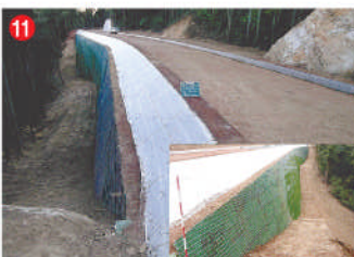
11 工事名 寺西2期地区農道工事 施工者 下條建設㈱ 技術者 橋口 武士 工事内容 農道の補強をする工事です。
