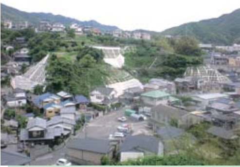
急傾斜地崩壊対策(毛井首地区)長崎市
