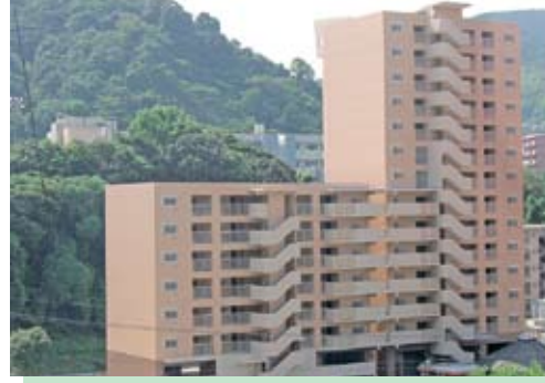
県営住宅(滑石団地2-3棟)長崎市
