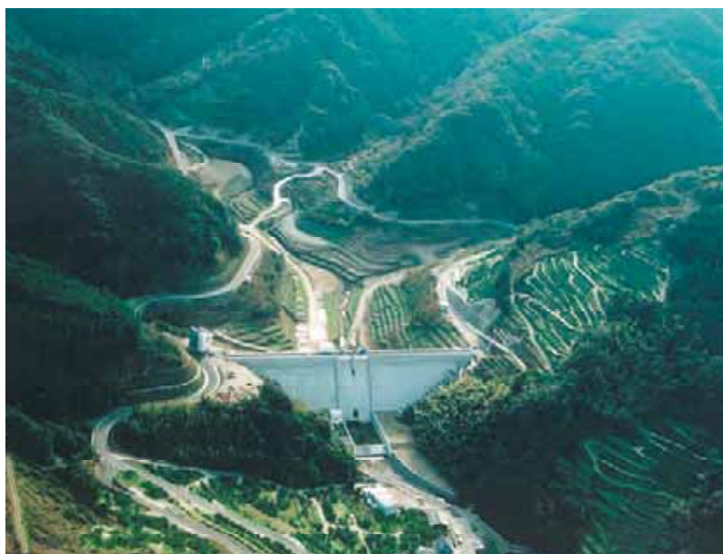
平成18年度、本体コンクリート部分が完成しました。
