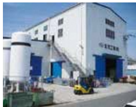
時津工場（製缶工場）
