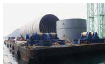
洋上風車ブロック海上輸送
