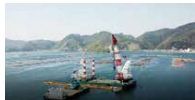
550 t 吊起重機船(第六長崎号)による浮体式防波堤設置作業状況
