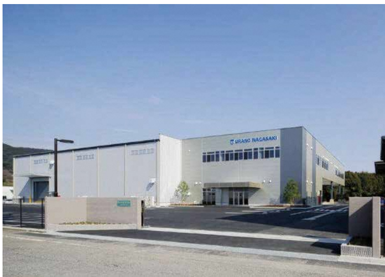
2016年3月建設完了した長崎第3工場外観
