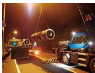
官公庁 トンネルファン撤去工事
