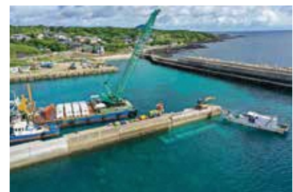
クレーン付台船70t 張ブロック4t据付
