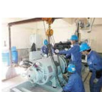
自衛隊 発電機整備工事
