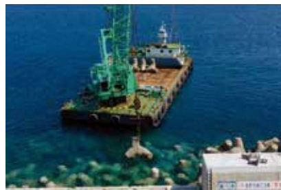
起重機船160t 消波ブロック20t据付
