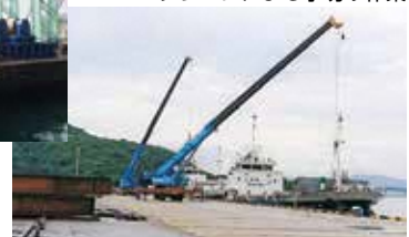
クレーンによる水切り作業
