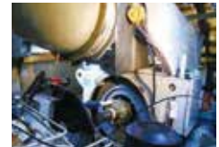
風力発電機ナセル内軸受け交換
