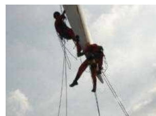
ロープワークによる洋上風車ブレード点検作業
