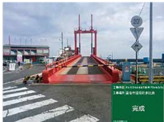
多比良港可動橋
