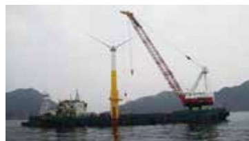
起重機船による五島沖の洋上風力設置状況
