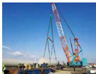
クレーン作業
