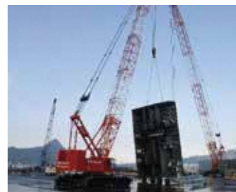
クレーン作業風景
