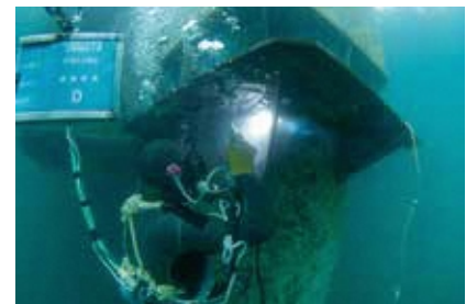
潜水士による水中溶接
