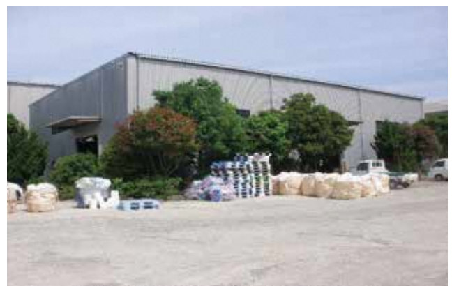
産廃処理工場
