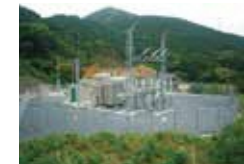
66kV/22kV変電所施工
