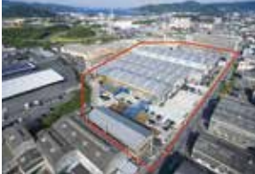
本社・工場外観 (空撮)
