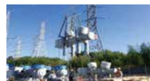
220kV遮断器据え付け工事
