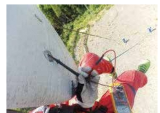
ロープワークによる導通確認作業
