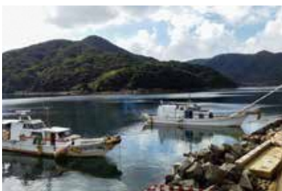
潜水士船による被覆石均し
