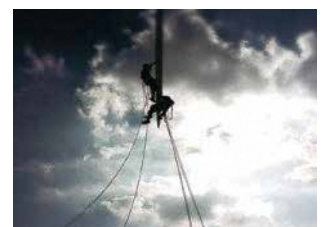
ロープワークによる導通確認作業
