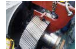
風力発電用増速機ナセル内分解整備
