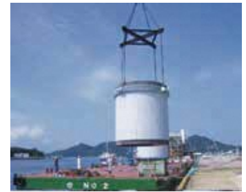
搬出・出荷作業風景
