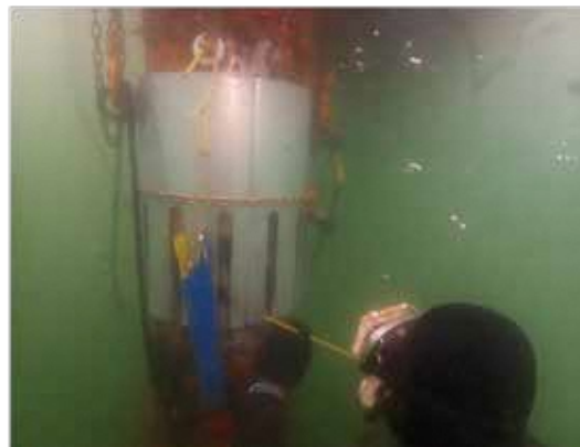
浮棧橋水中施工状況
