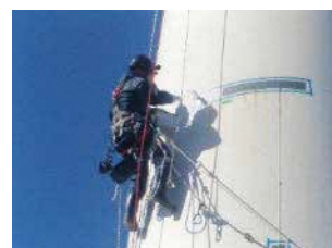
ロープワークによるタワー塗装
