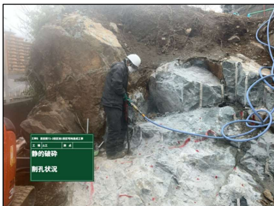
硬岩破碎状況
