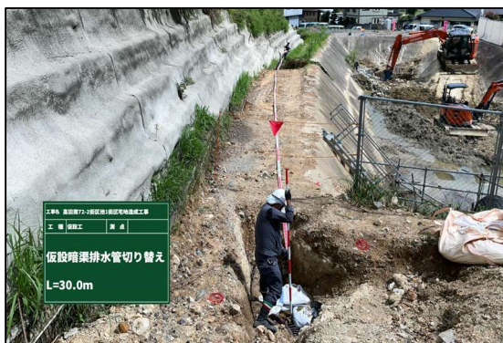
排水管切り回し前
