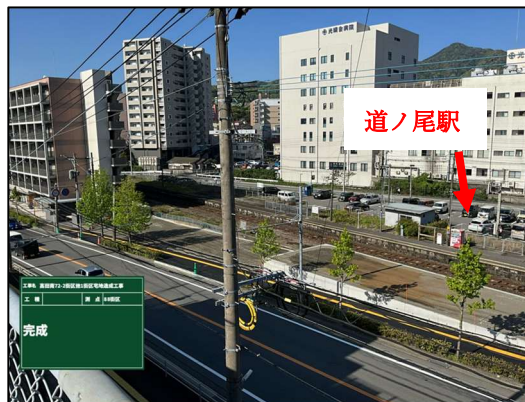
88 街区工事完了後
