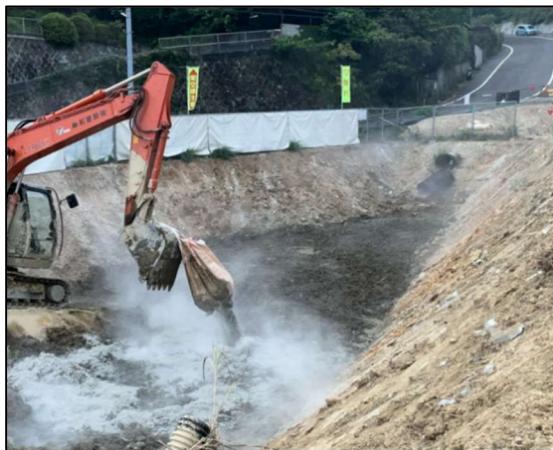
石灰混合状況
