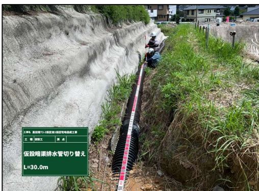
排水管切り回し後
