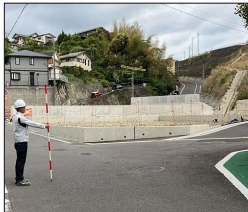
72-2 街区工事完了後
