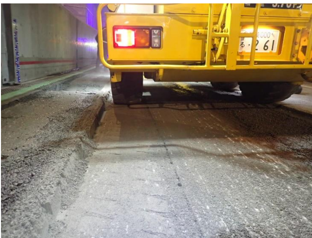
写真－4 切削完了状況
