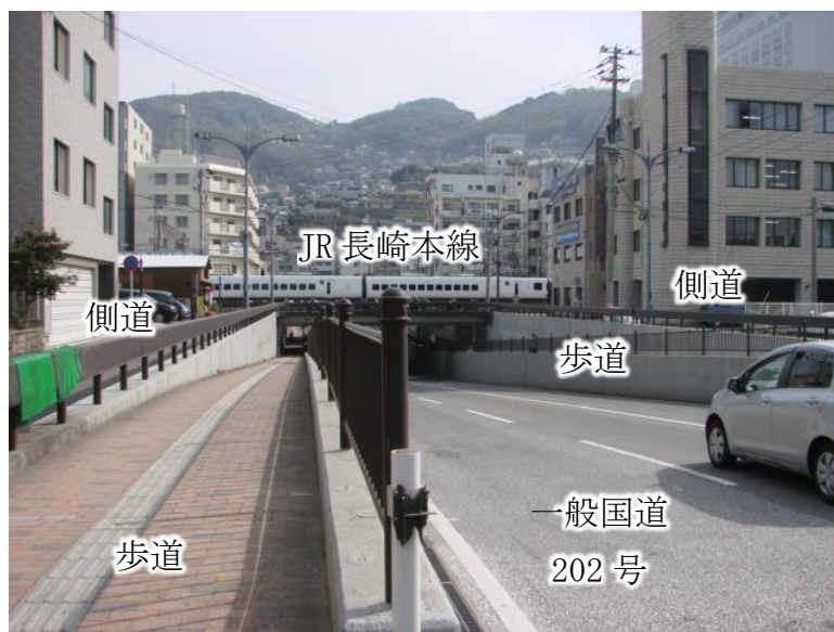
写真－1 稲佐橋方面から見た稲佐立体交差部 （事業前）
