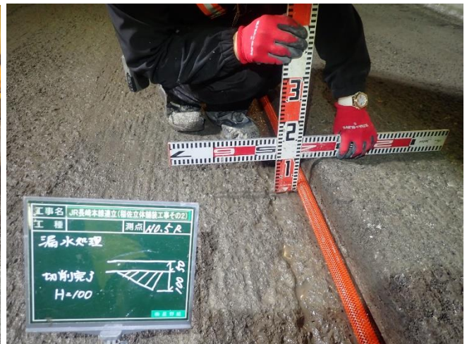
写真－5 地下排水管設置状況
