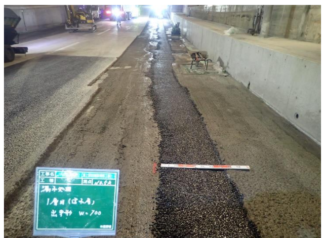
写真－7 基層施工完了状況
