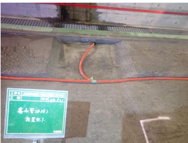
写真－6 地下排水管設置状況 (側溝接続部)
