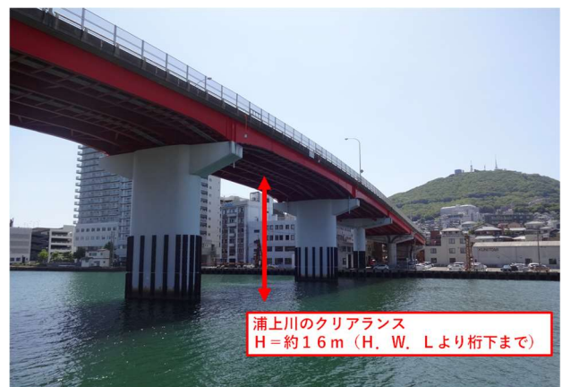
図2 旭大橋の状況写真
