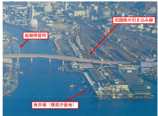
図1 昭和57年の旭大橋付近の状況写真
