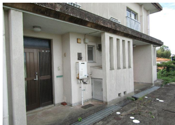
玄関(北側)より撮影
