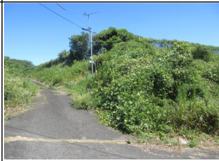
南側道路から (南西側法地部分)
