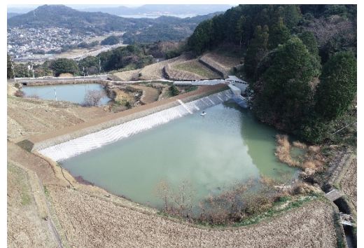
防災重点農業用ため池整備 （中堤ため池：松浦市）
