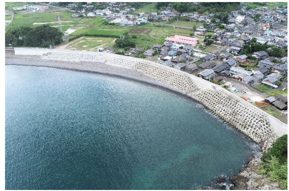
農地海岸施設整備 (簿山地区：平戸市)
