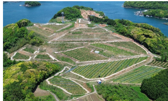
樹園地の基盤整備（小迎地区：西海市）
