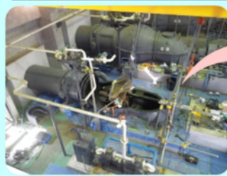
排水ポンプの分解整備
