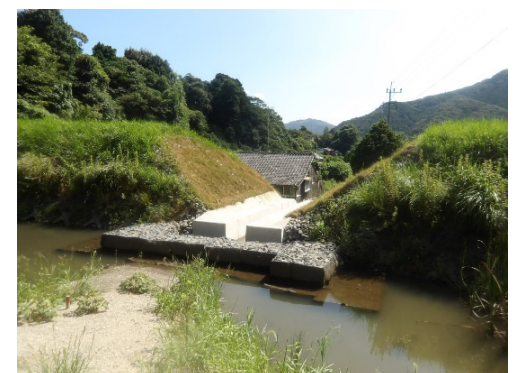
堤体開削によるため池廃止 （内裏池：佐世保市）
