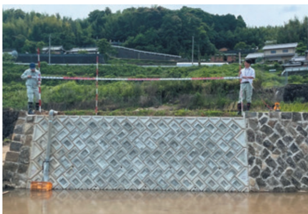
復旧完了（農地・田） 令和4年度災害（諫早市）
