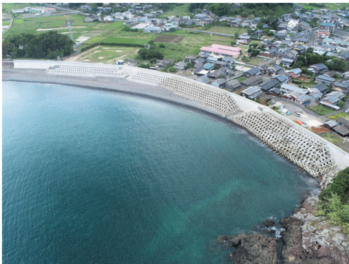
簿山地区の護岸工 (平戸市)
