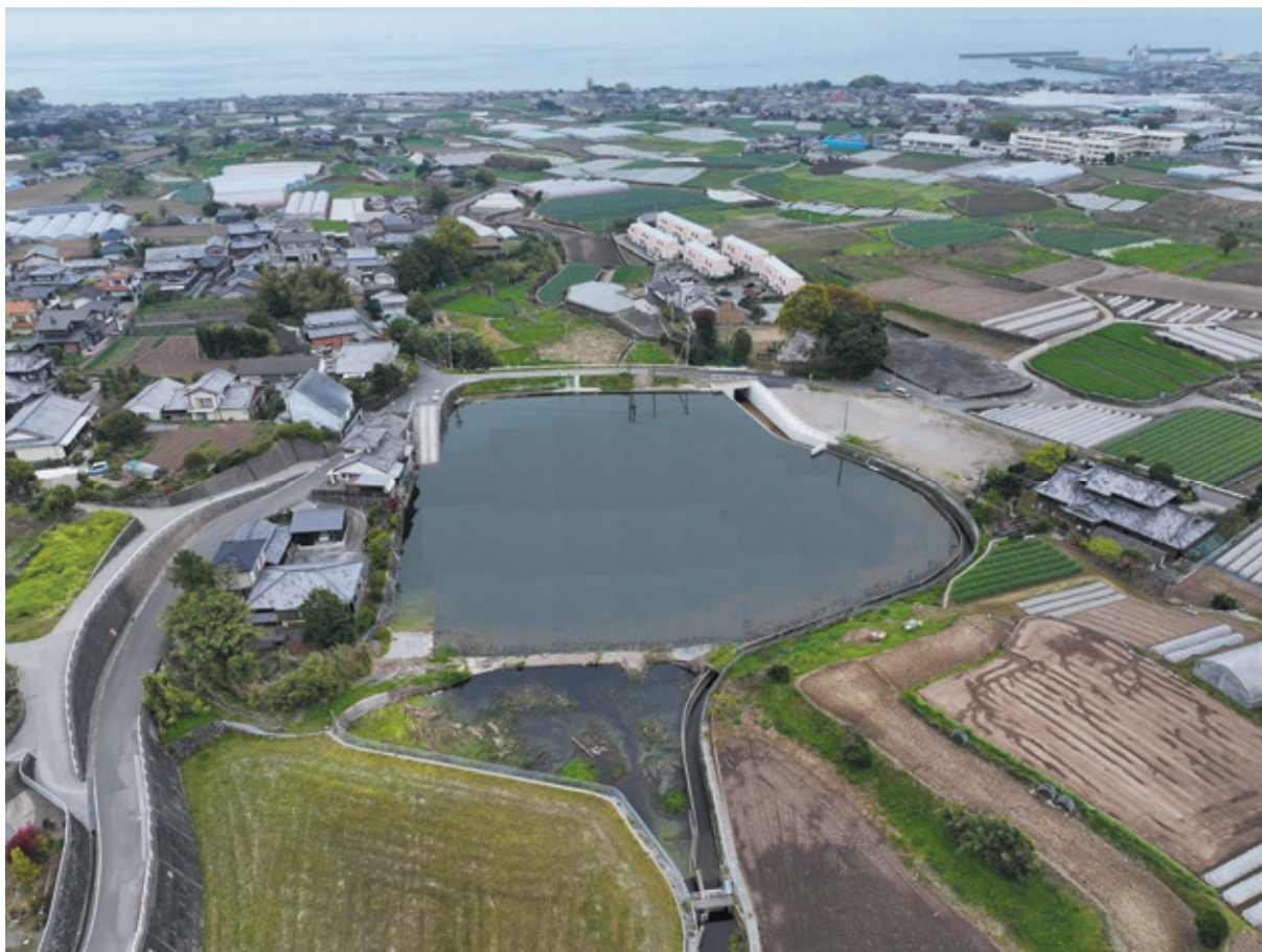
島原地区 寺中ため池（島原市）
