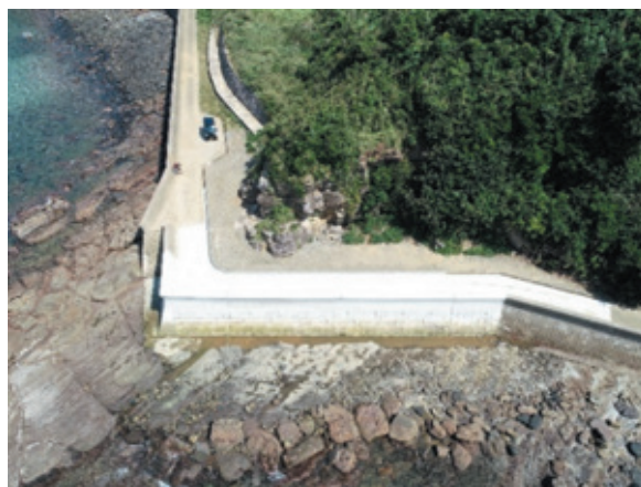
復旧完了（農地海岸） 令和3年度災害（松浦市）
