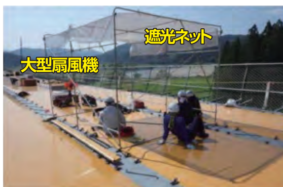
～メッシュシートによる遮光設備と大型扇風機の設置～
