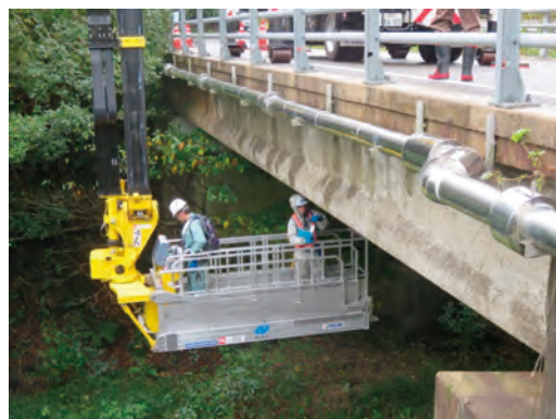
橋梁の定期点検状況
