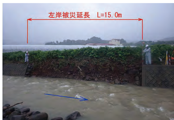
被災箇所 の 測量
