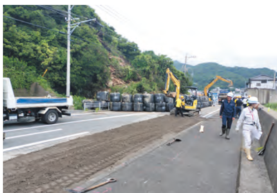
落石等による被害の復旧作業
