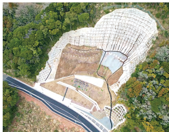
令和7年度概成（R1・R3被災箇所） 高野地区地すべり対策事業（松浦市）
