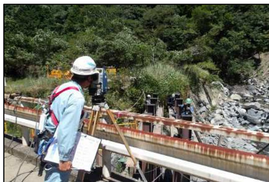
【現場確認状況（支持杭確認）】
