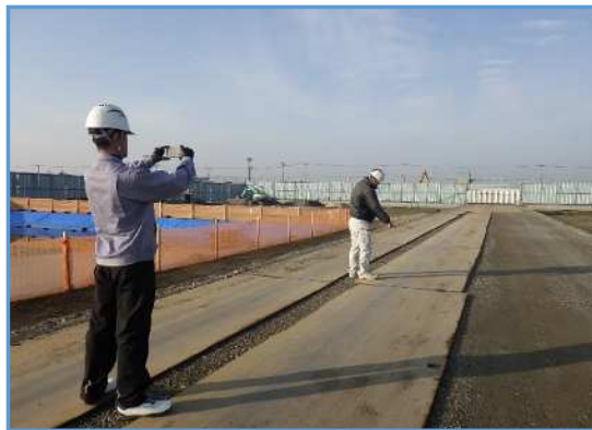
【立会状況（現場側）】
