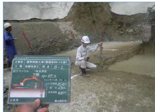
【出来形管理（杭ナビ測量）】
