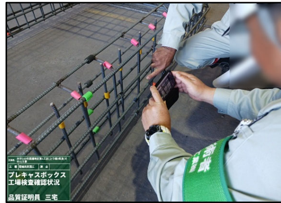
【鉄筋マーカーによる表示】
