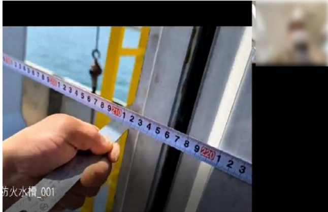
【近景撮影状況(防火水槽材料確認)】
