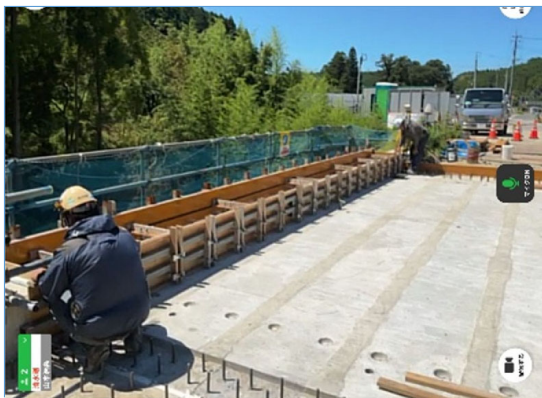
【立会状況（地覆型枠検測）】
