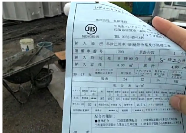
【立会状況 (現場側)】
