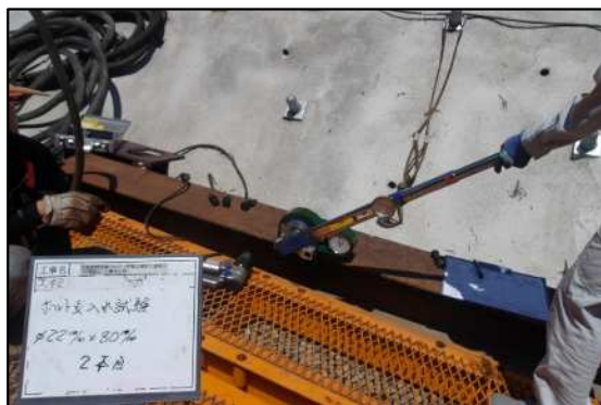
【現場確認状況（トルクレンチ確認）】
