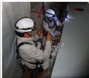
【測定箇所に照明を設置】
