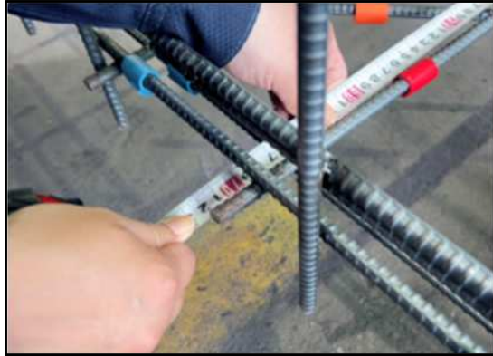
【立会状況（配筋確認；近接）】
