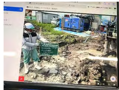
【立会状況（監督側）】
