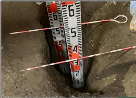
【立会状況（路盤出来形確認）】
