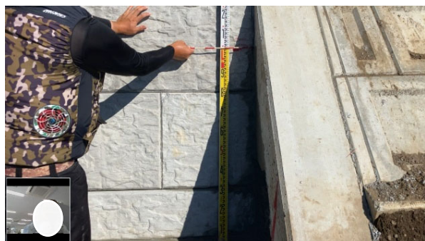
【遠隔臨場確認状況（床掘基準高確認）】 【遠隔臨場確認状況（床掘基準高確認）】
