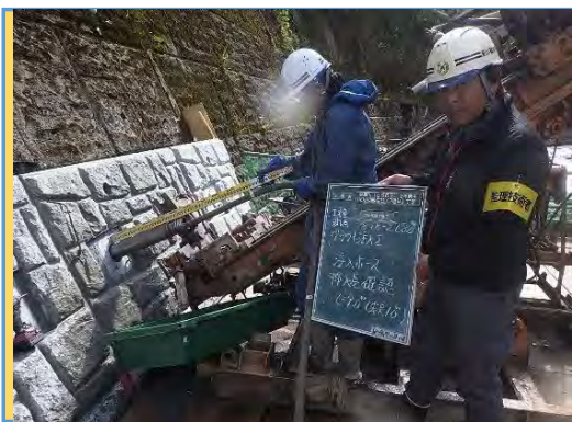
【立会状況(施工状況)】
