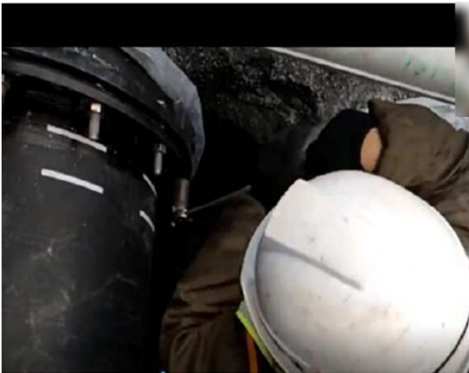
【立会状況（現場側） 締付トルク確認】
