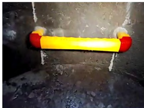
【オンライン検査（足掛金物取付確認）】
