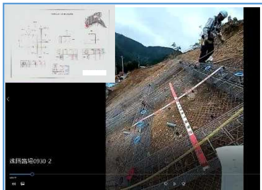
【立会状況（現場側）】
