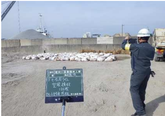
【立会状況（現場側）】
