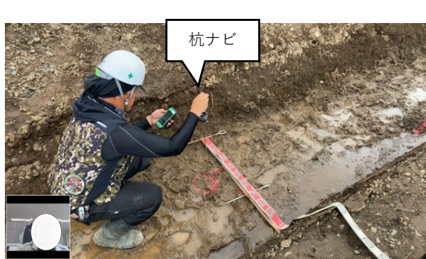
【遠隔臨場確認状況（床掘基準高確認）】 【遠隔臨場確認状況（床掘基準高確認）】
