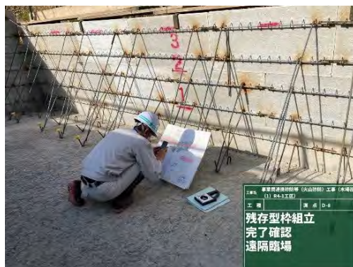
【立会状況（現場側）】
