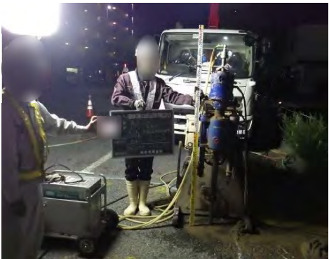
【現地状況（薬液注入ロット検尺）】
