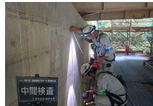
【立会状況（現場側）】
