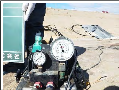
【緊張力を確認（現場側）】
