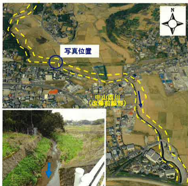
改修前（平成2年撮影）
