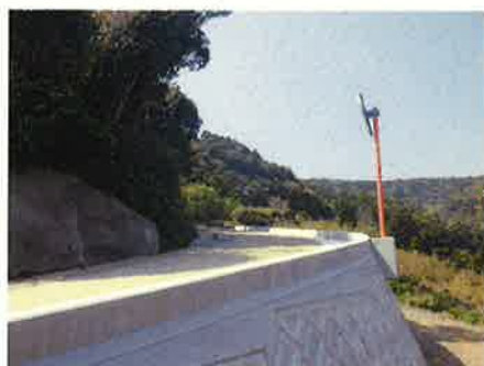
既存道路改良状況
