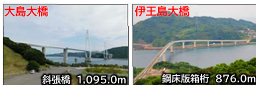
▲第1期事業対象橋梁
