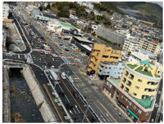
大神宮工区(大神宮交差点)の工事状況
