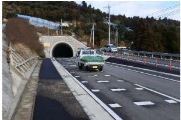
平成29年2月に供用開始した茂木工区
