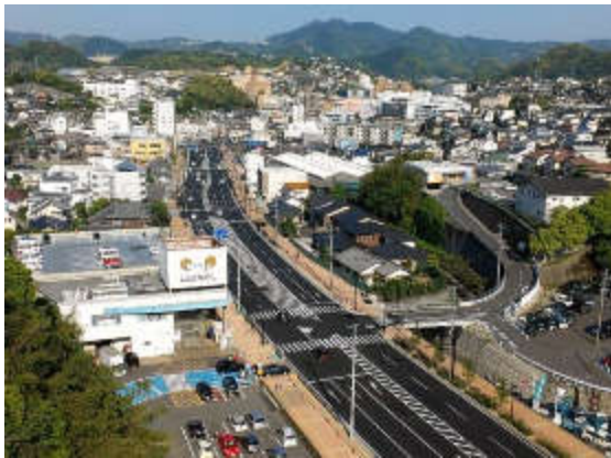
横道工区の供用状況
