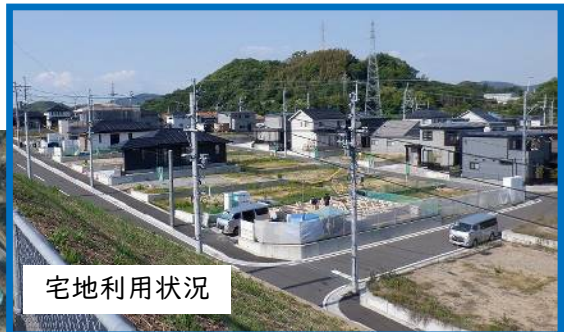
令和7年3月工事概成
