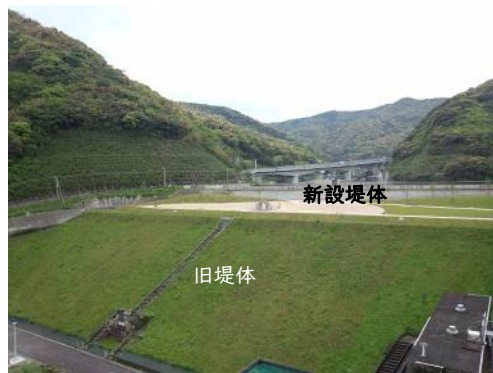
公園整備(平成 25 年 3 月完了)
