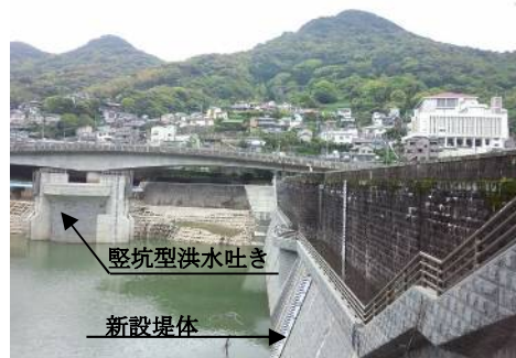
低部ダム上流状況
