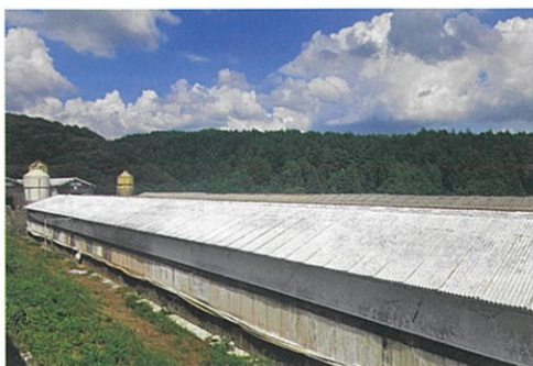
消石灰を塗布した屋根
