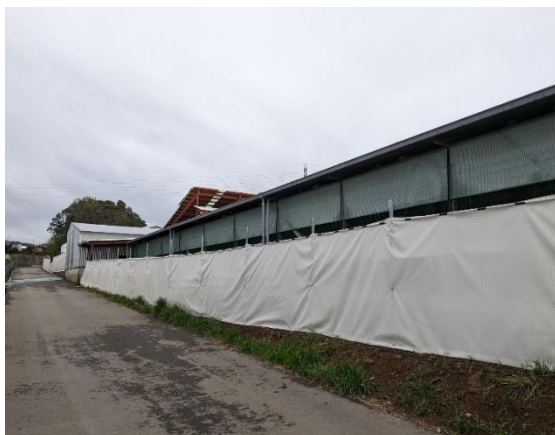
臭気低減ネットの設置
