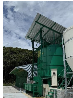
家畜排せつ物処理施設の整備
