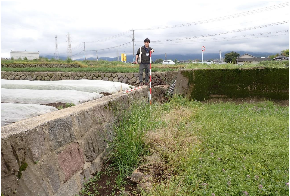
図2 撤去箇所①現況
