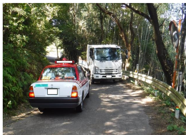
図● 1車線道路の離合状況（一般国道207号）
