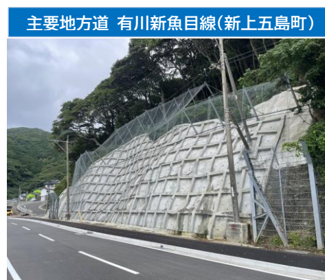
図 ● 道路法面对策状況
