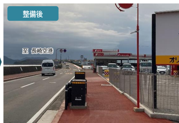
図 ● 第一次緊急輸送道路における無電柱化
