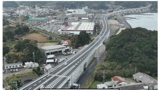
西九州自動車道
