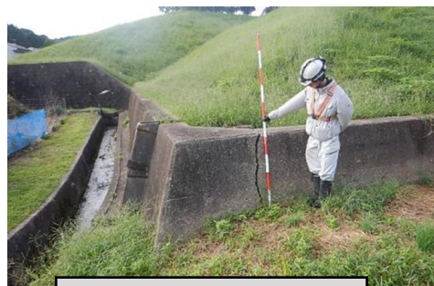
既存盛土等の基礎調査
