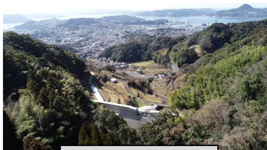
福石川(砂防堰堤)
