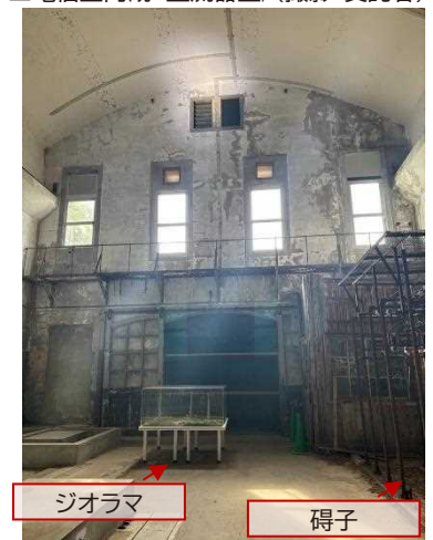
▲電信室内観 機械室/(撮影:受託者)
