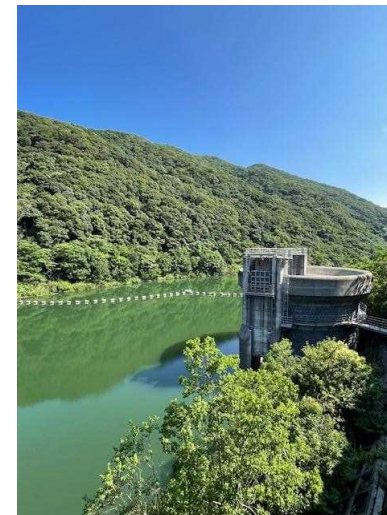
【低部】縦穴型トンネル式洪水吐の上部。アクセス可能だがルート整備されていない
