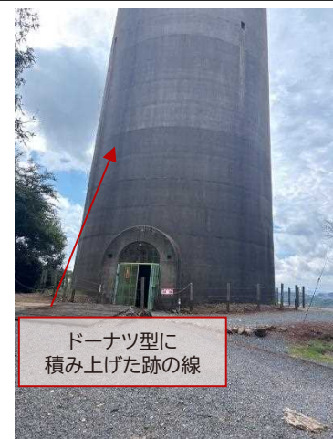
▲針尾無線塔3号塔外観(撮影:受託者)
