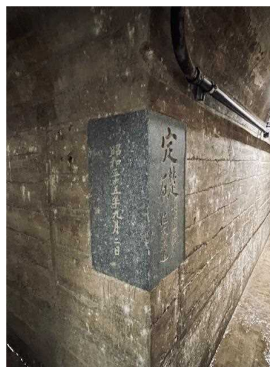
当初建設時の定礎。監査廊ルート上にある
