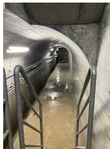
【低部】見学可能な監査廊は短く段差なし
