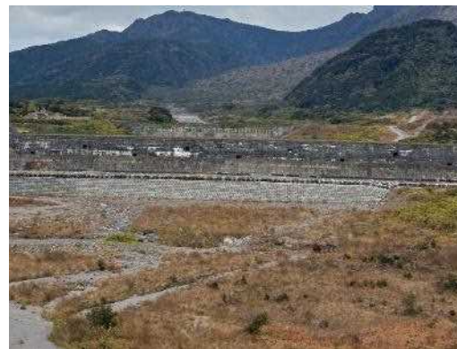
水無川1号砂防堰堤より上流を望む スリットや上流の堰堤が連なる様を見ることが できる。
