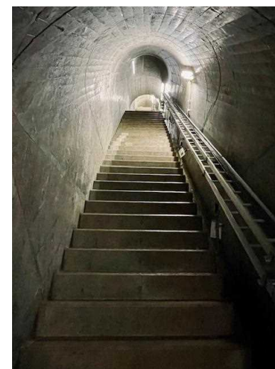
【高部】監査廊の階段は、長さ(高低差)の負担は大きくないが、片方の段差が急で、全てに手すりなし
