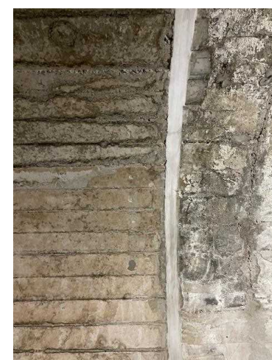
かさ上げ工事の際の継ぎ目
