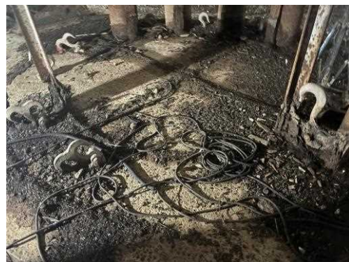
▲針尾無線塔3号塔内部 電線を固定していた場所/ (撮影:受託者)
