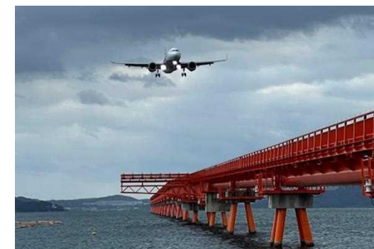
誘導灯の上から降りてくる飛行機。着陸時間に合わせて見学させる運用が困難。
