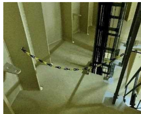
主塔内部、安全管理用のトラチェーン
