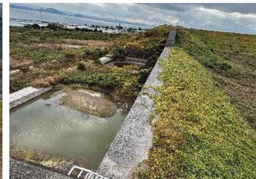
通常は安全のため立入禁止の水無川1号砂防 堰堤(立入禁止区域ではない)
