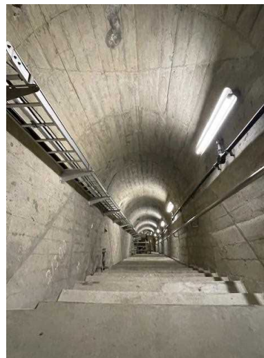
監査廊の急階段。全編手すりあり
