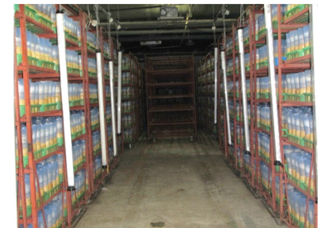
蛍光灯からLEDへの転換 (例：きのこ生産施設)
