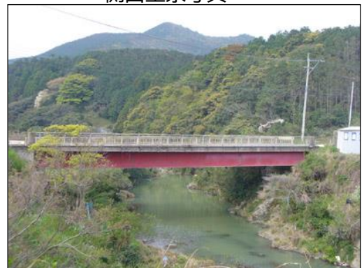
側面全景写真
