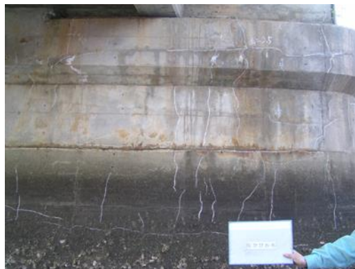
橋脚-ひびわれ, 漏水・遊離石灰
