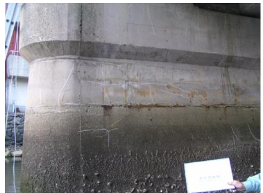
橋脚-ひびわれ, 漏水・遊離石灰
