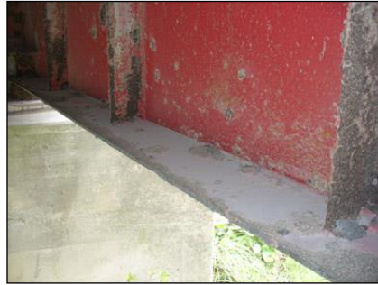
主桁-腐食
