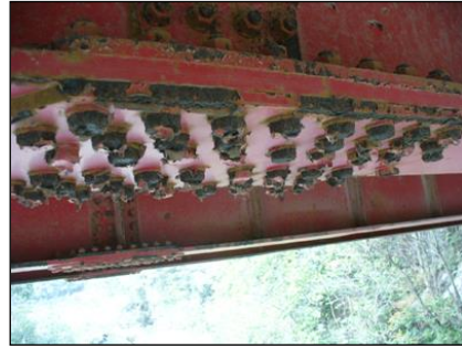
主桁-腐食
