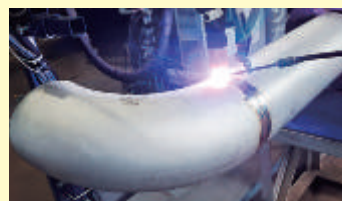
配管溶接の様子 (提供:石田エンジニアリング(株))
