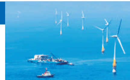
五島市沖の浮体式洋上風力発電 (提供:戸田建設(株))
