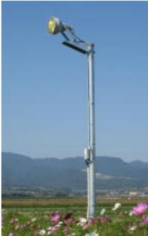
写真-5-20 黄色高圧ナトリウムランプ(270W) 使用の黄色灯
