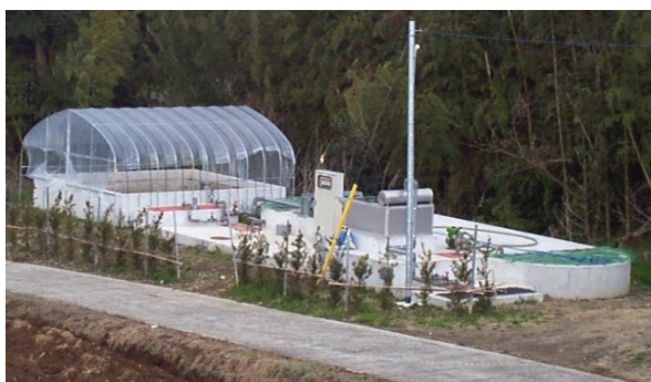
写真 58 畜産研究部門の回分式活性汚泥法のオキシデーションディッチタイプ畜産污水浄化施設
