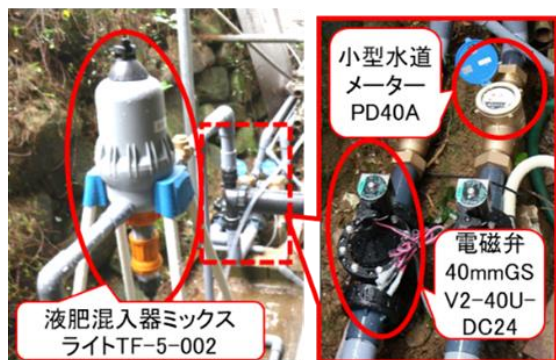
クラウド型自動かん水・液肥施用システムを利用したマルドリ栽培
