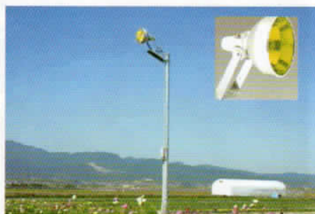
高圧ナトリウムランプ(270W) 使用の黄色灯
