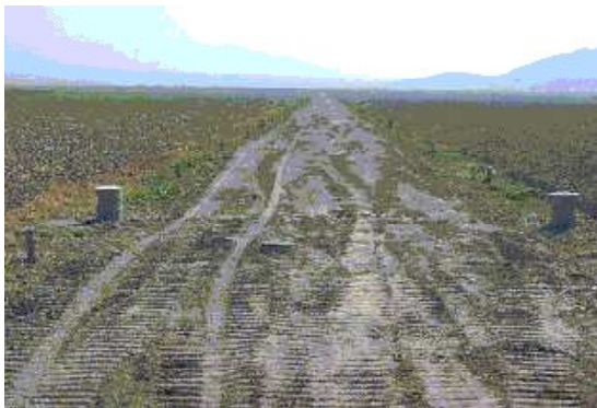
耕作道路の整備状況 (今後、幅5.5mの砂利舗装で仕上) (両側に給水栓あり)
