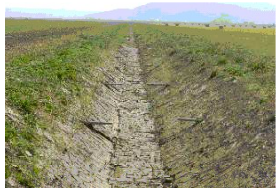
小排水路の整備状況 (暗渠排水管を10m間隔で配置)
