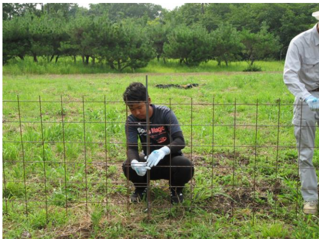
(鳥獣対策)ワイヤーメッシュと支柱を固定する様子
