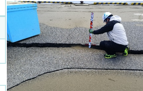
漁港の被害状況の調査
