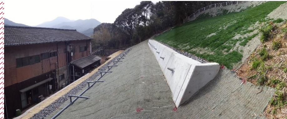
地中の岩盤にワイヤー固定し 地すべりを縫い付け、地すべり防止を図る工事
