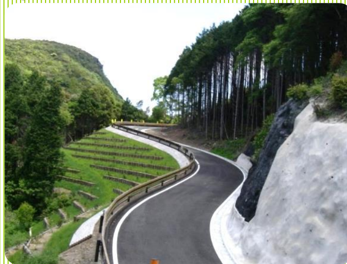
②林道（林業専用道）の開設
