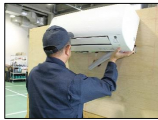
▲ 冷媒配管の施工と 空調機器据付け技術
