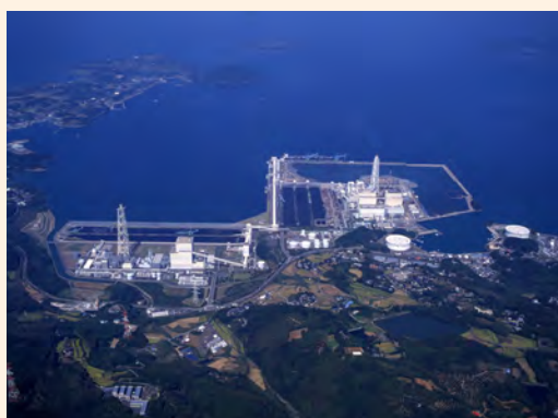
松浦火力発電所
