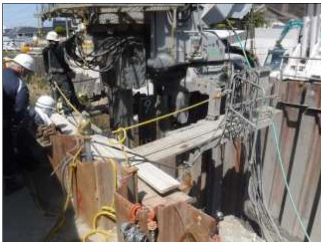
硬質岩盤クリア工法による橋梁下部工締切状況
