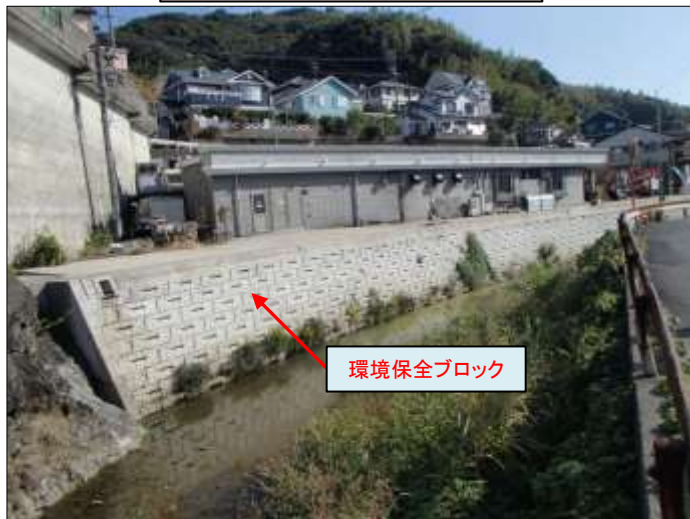
長坂橋上流側護岸工
