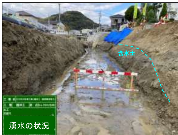
湧水及び軟弱地盤の状況
