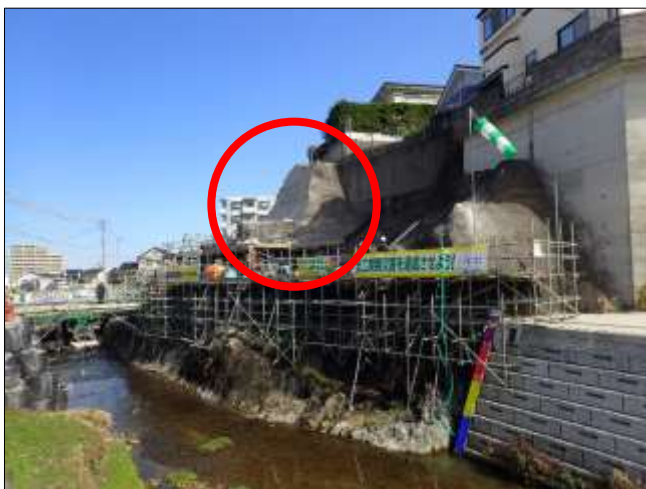
ワイヤーソー工法による山切状況
