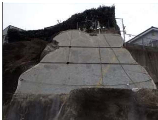
ワイヤーソー工法による山切状況
