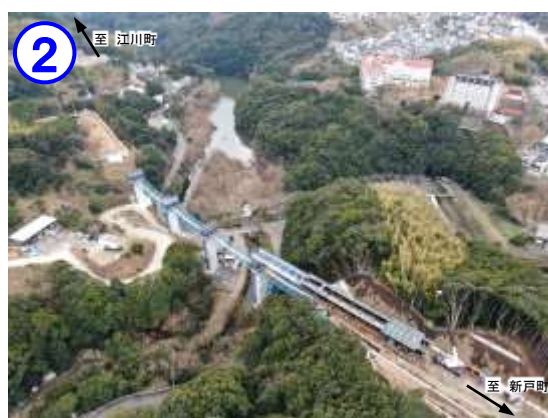
3号橋施工状況
