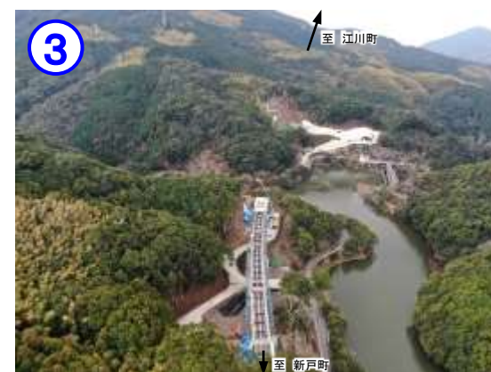
8号橋施工状況
