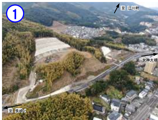
新戸町IC施工状況
