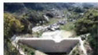
西崎山上野石町大谷川の防災整備
