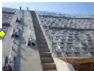
整備された取水施設
