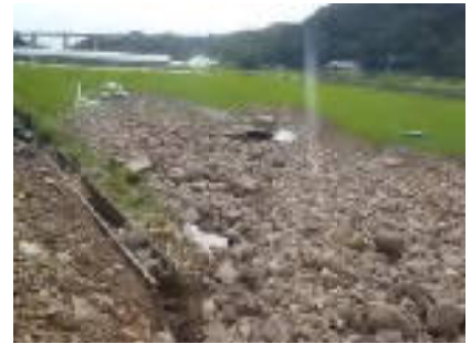
佐奈河内川 周辺農地 被災状況
