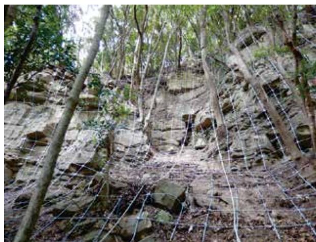
落石による被害を防止し人家等を守る固定工
