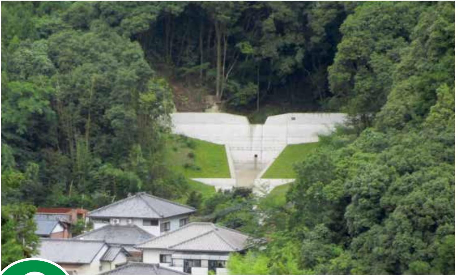
土砂災害から県民を守る治山ダム
