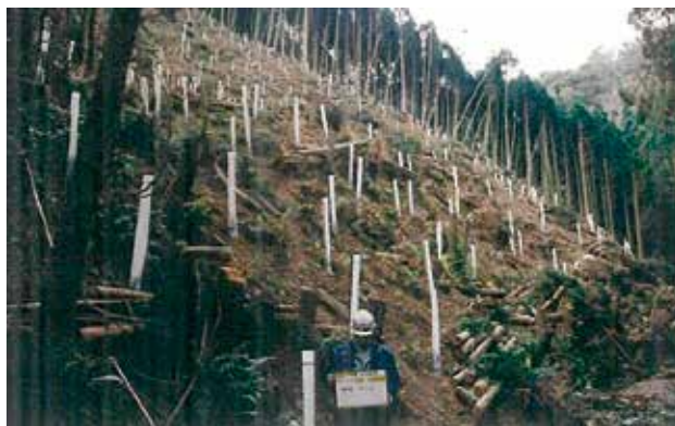
ツリーシェルター施行後
