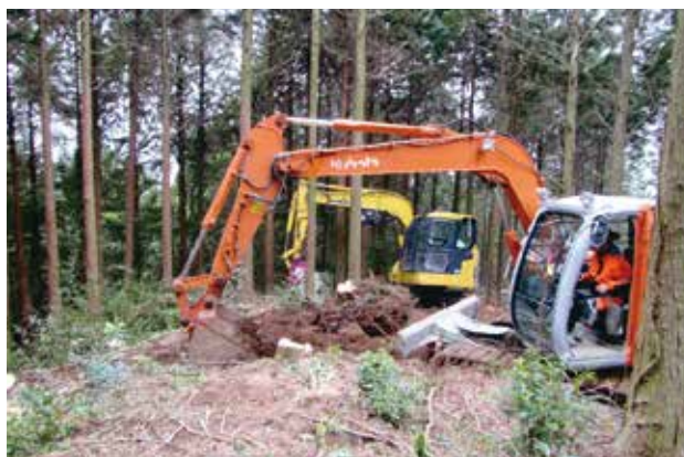
- 重機を用いた作業の様子 -
