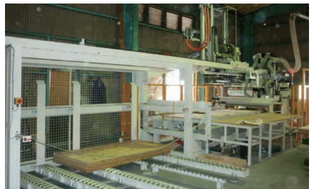
令和元年に整備した木材加工施設（諫早市）
