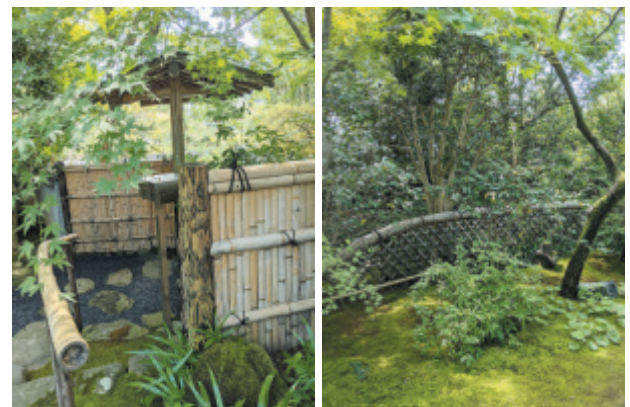
（左）山から切出した緩やかな曲線の竹は手すりに （右）庭の樹木に自然に溶け込んだ手作りの竹垣
