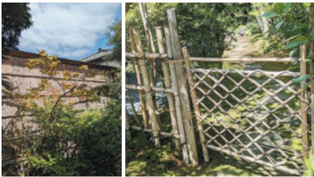
(左) 吉野杉の皮を1枚ずつ張り合わせた杉皮壁 (右) 内と外の空間を分ける茶庭の竹垣
