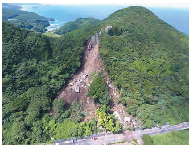
平戸市 しゅうしちやう 主師町 しらいし 白石地区 （治山事業施工中） （令和2年7月豪雨による被災箇所）
